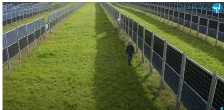
1 : panneaux photovoltaïques bifaciaux
