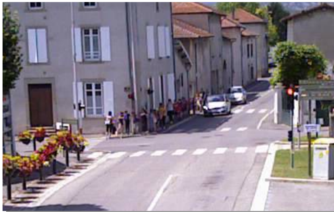
Carrefour Avit Nicolas / Delaune / Rebatière : largeur de trottoir insuffisante dans le carrefour. Il n'y a pas de solution évidente car l'espace est compté, la largeur de la chaussée est déjà proche de son minimum (sauf à mettre un sens unique, scénario discuté par la suite). Un éventuel achat de la propriété à l'angle libérerait de l'espace pour les modes actifs.
