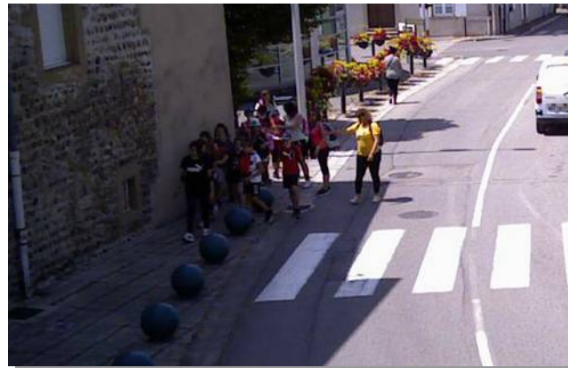
Rue Avit Nicolas : largeur de trottoir insuffisante localement. Un ré-aménagement local bénéficiant aux piétons est possible.
