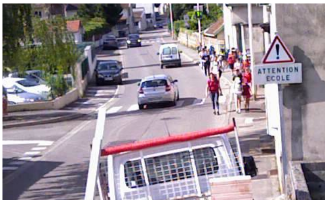
Rue Delaune : absence de trottoir & largeur de trottoir insuffisante vu l'usage scolaire. A contrario l'offre de stationnement est excédentaire. Le choix existant de répartition modale de l'espace de la rue est à discuter et éventuellement à ré-équilibrer.
