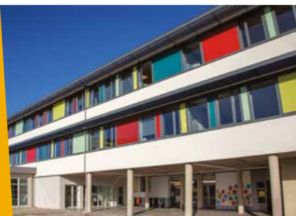
Rénovation thermique du groupe scolaire Joliot-Curie
